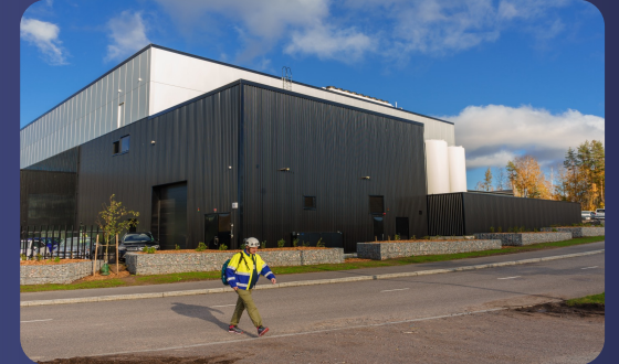
Solar Foods Oy elektrolyysin sähköasennustyöt 2023
