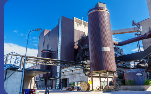
Fortum Oy huolto- ja muutos-sähkötöitä vuodesta 1996. Sähkökattilaurakka 2022 – 2023
