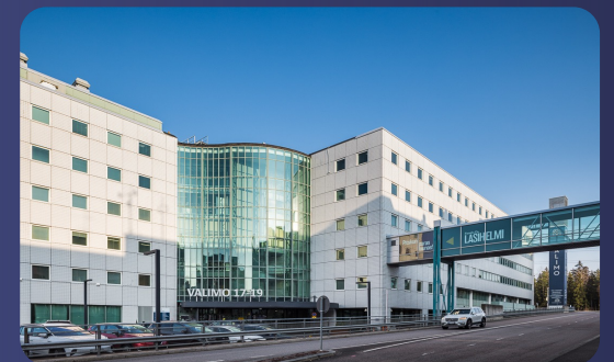
Käytönjohtajuuksia -esimerkiksi koy Helsingin Valimotie 17 – 19 (4 muuntajaa), koy Myyrinpuhos, koy Asemapäällikönkatu ja Hämäläisten ylioppilassäätiö
