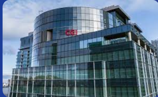
CGI Oy:n tietoverkko- ja sähkömuutostöitä vuodesta 1995
